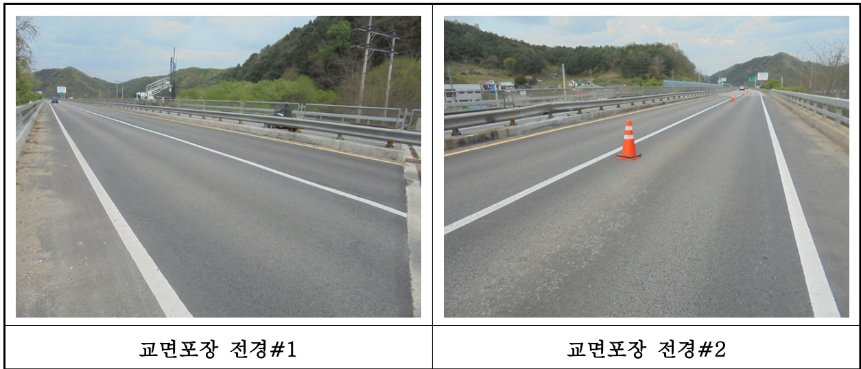
【사진 1.3.19】 교면포장 전경
