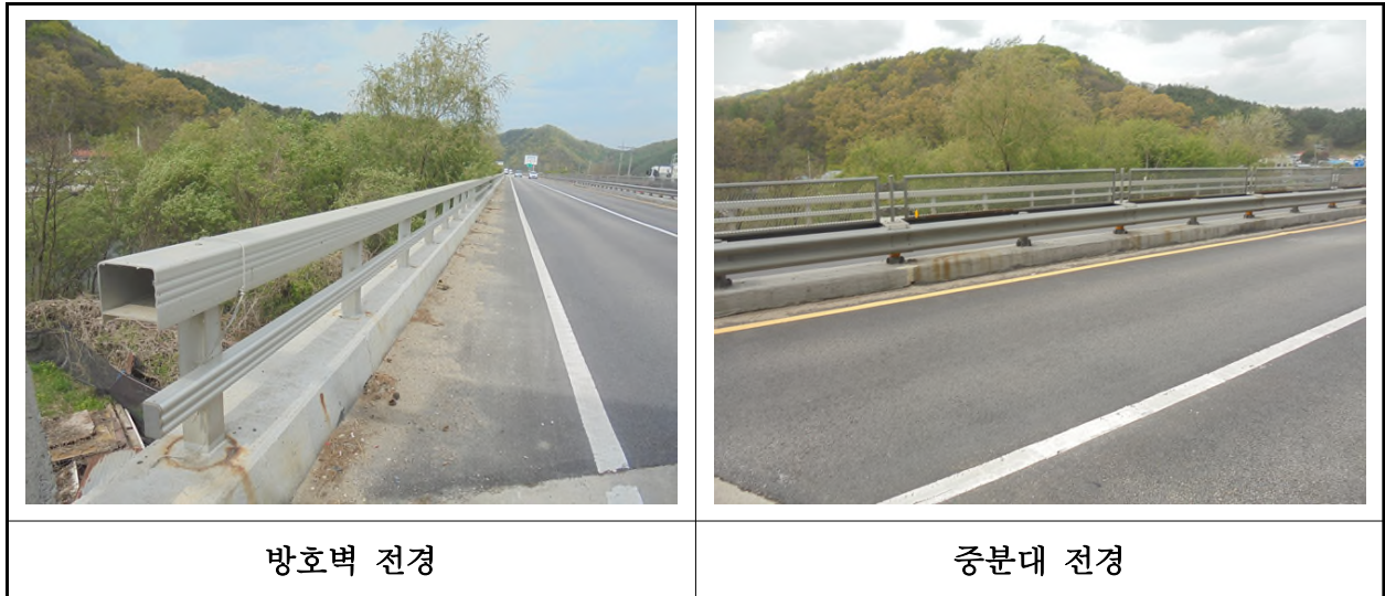
【사진 1.3.23】 방호벽 및 중앙분리대 전경
