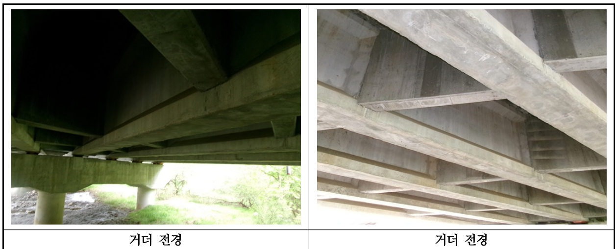
【사진 1.3.4】 거더 전경
