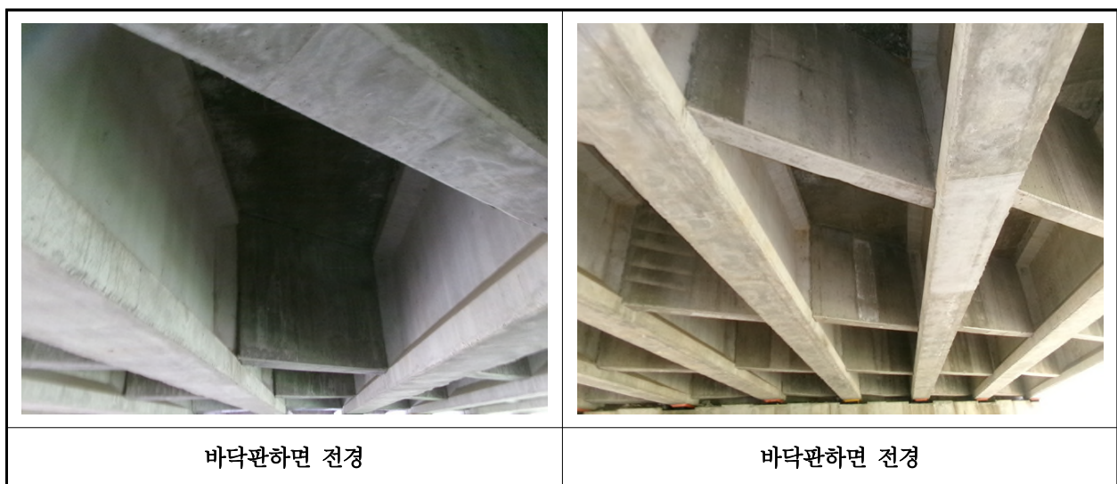
【사진 1.3.2】 바닥판하면 전경
