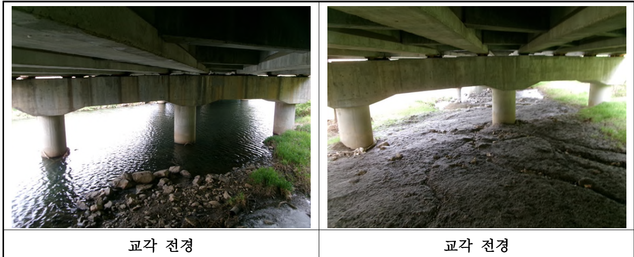
【사진 1.3.10】 교각 전경
