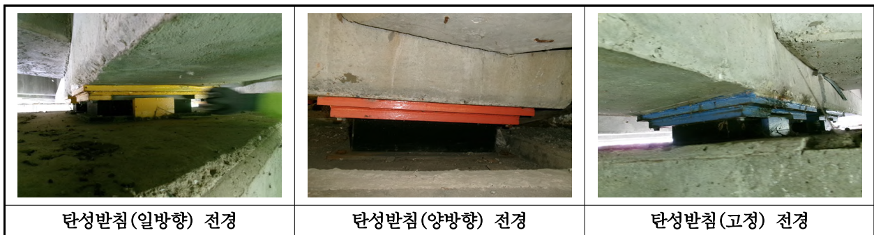
【사진 1.3.12】 교량받침 전경
