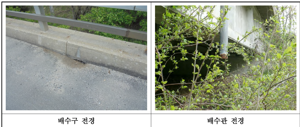
【사진 1.3.21】 배수시설 전경
